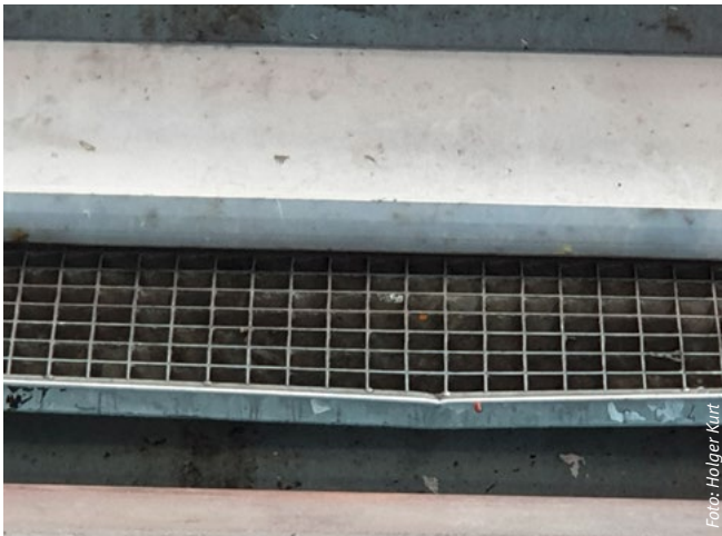
Verformter Gitterrost
