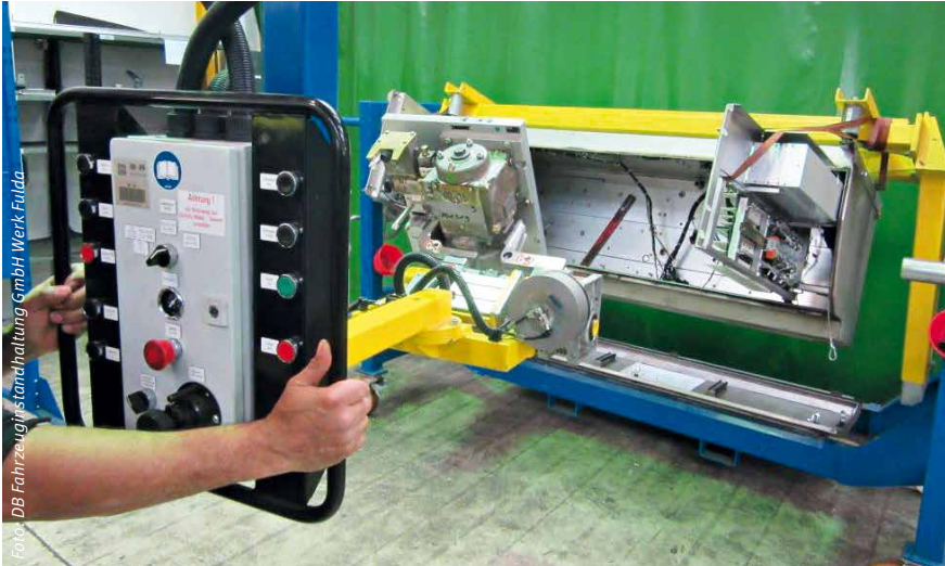
Abbildung 6: Mit dem Lastenmanipulator werden die bis zu über 50 kg schweren Modulplatten aus dem Bremscontainer gehoben
