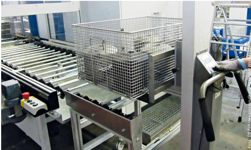
Abbildung 2: Mit dem Elektro-Lifter werden die Waschkörbe mit den Grundkörpern auf das Förderband für die Reinigungsanlage transportiert
