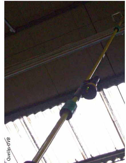
Feststellen der Spannungsfreiheit an der Stromschiene-Fahrleitung
