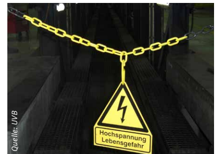
Absperren des Gefahrenbereiches
