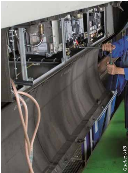
Arbeiten an elektrischen Anlagen am Schienenfahrzeug
