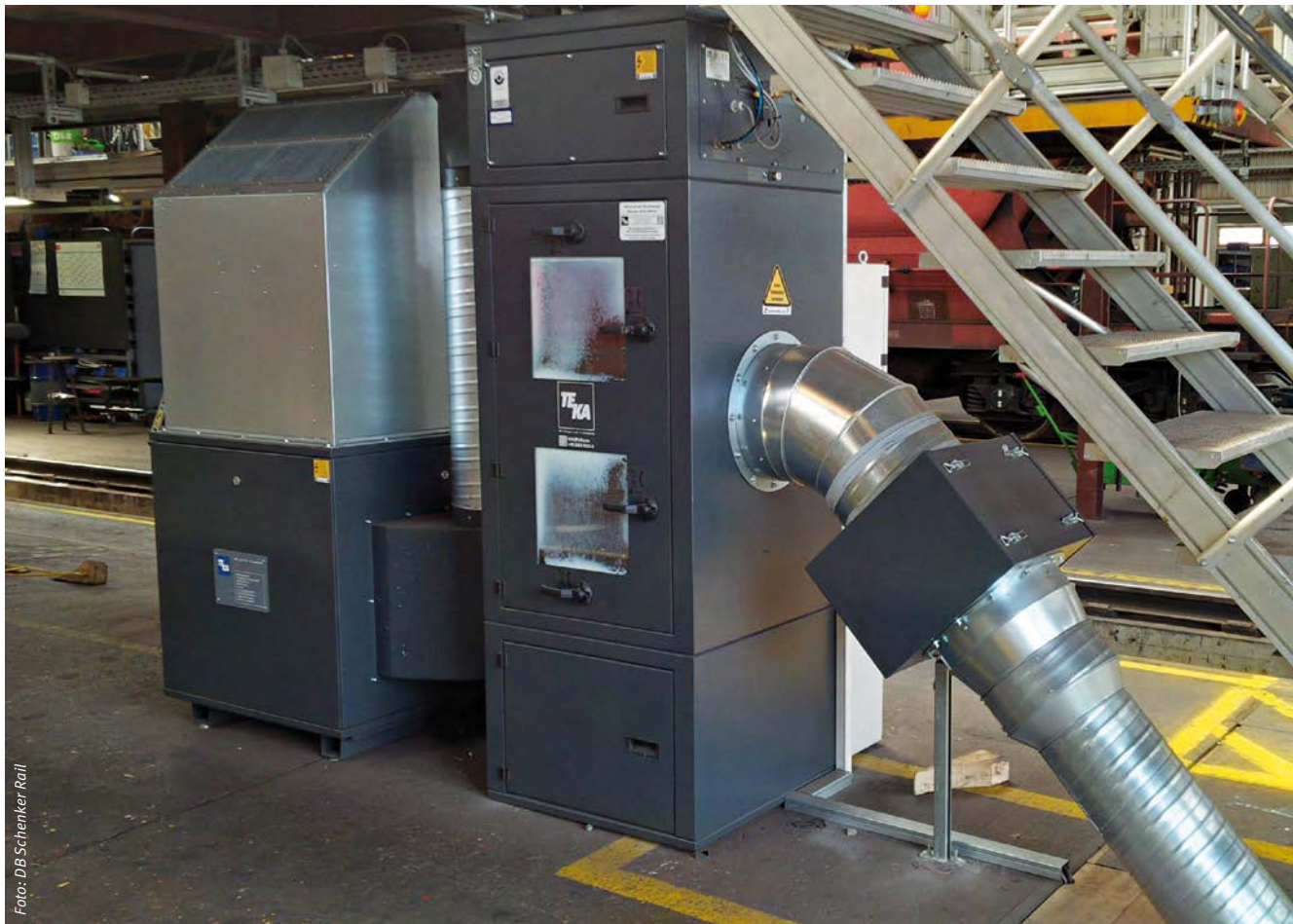
Abbildung 5: Absauganlage
