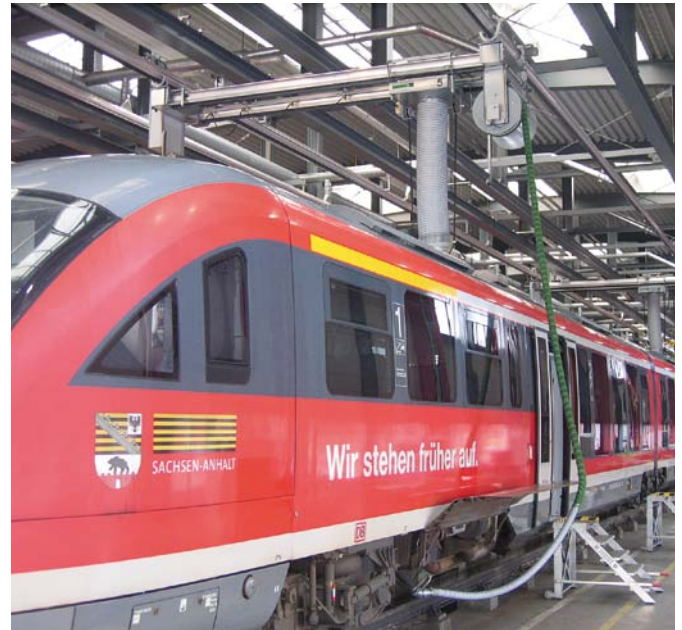
Abbildung 4: Positionierung der Absaughaube über dem Abgasstutzen auf dem Fahrzeugdach mit Anschluss an das Vorwärmgerät.
