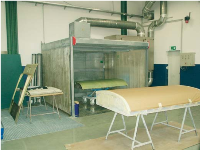
Abbildung 3: Laminierkabine mit integrierter Absaugung für die Bearbeitung von glasfaserverstärkten Kunststoffteilen.
