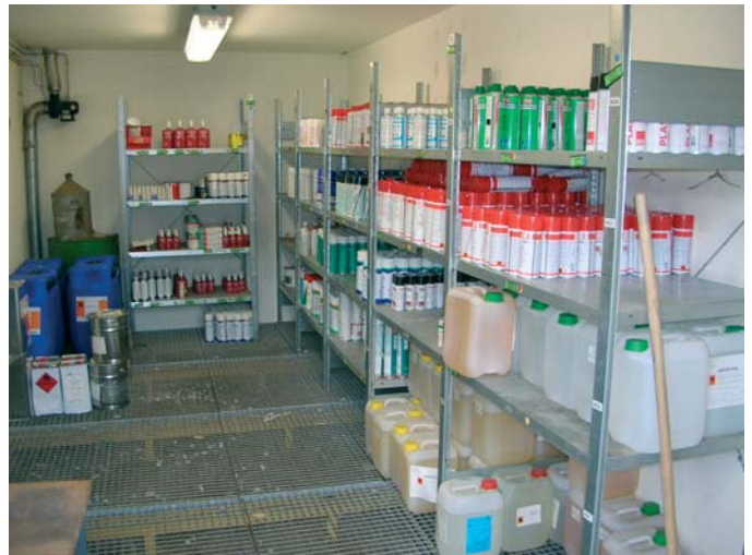
Abbildung 2: Lager für brennbare Flüssigkeiten.
