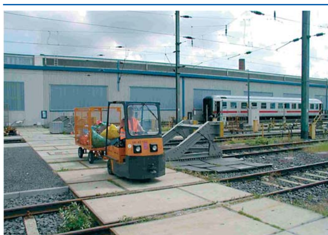
Abbildung 4: Verkehrswege müssen ausreichend bemessen sein und eine ebene Oberfläche ohne Stolperstellen haben (GUV-I 835).
