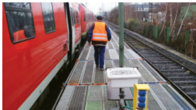
Abbildung 6: Außenwaschanlage. Durch Gitterroste läuft Waschwasser auch im Winter besonders leicht ab.
