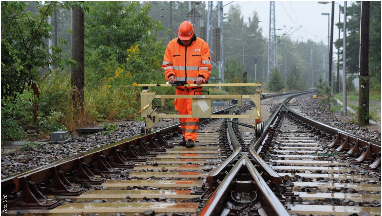
Abbildung 1: Tätigkeiten im Freien – Instandhalter beim Vermessen der Gleisgeometrie
