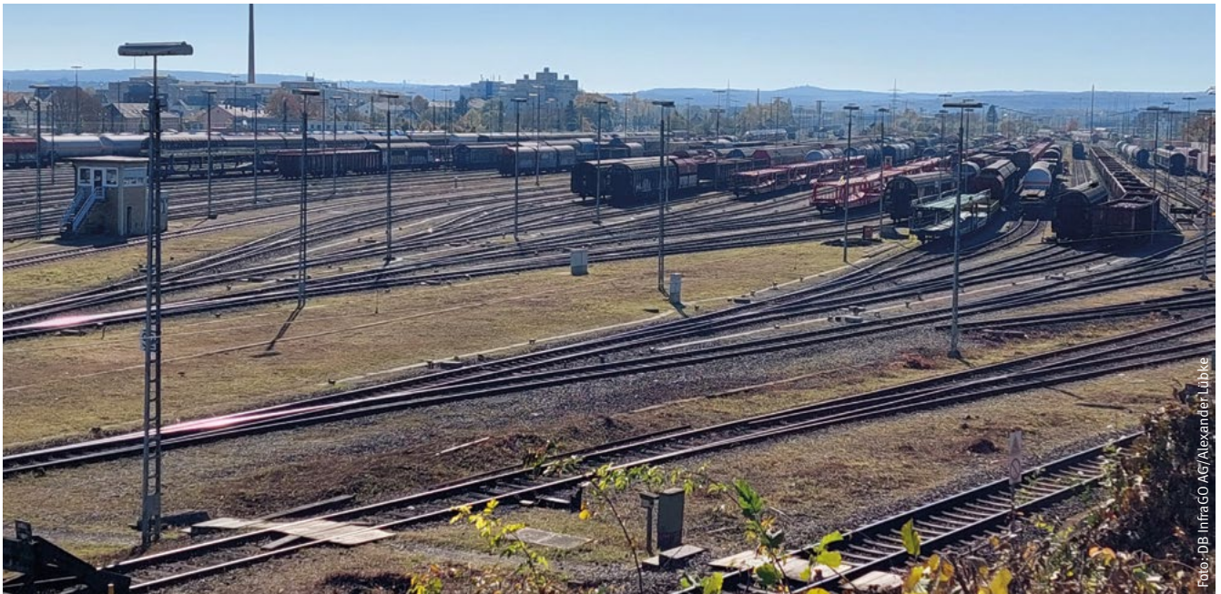
Abbildung 3: Beleuchtungssystem als Mastbeleuchtung mit einer Lichtpunkthöhe von 8 bis 14 m
