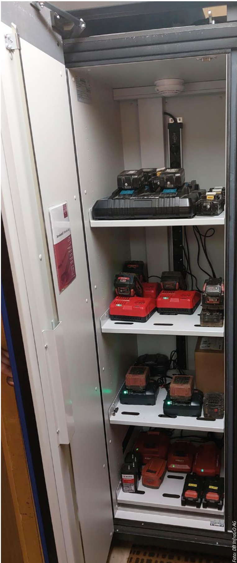
Abbildung 3: Sicherheitsladeschrank bei der RIS Nürnberg
