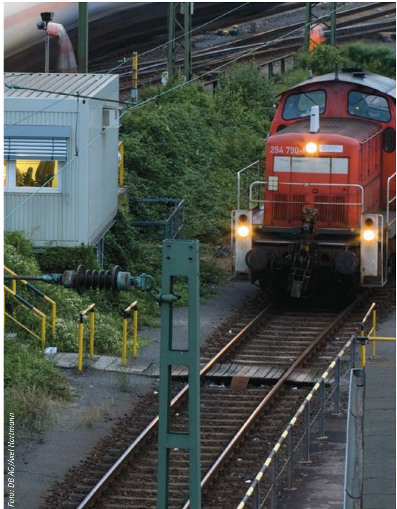
Abbildung 3: Holzbohlen sollen für Gleisüberwege nicht verwendet werden, da diese bei Feuchtigkeit oder Reifglätte nicht ausreichend rutschhemmend sind und eine Unfallgefahr darstellen
