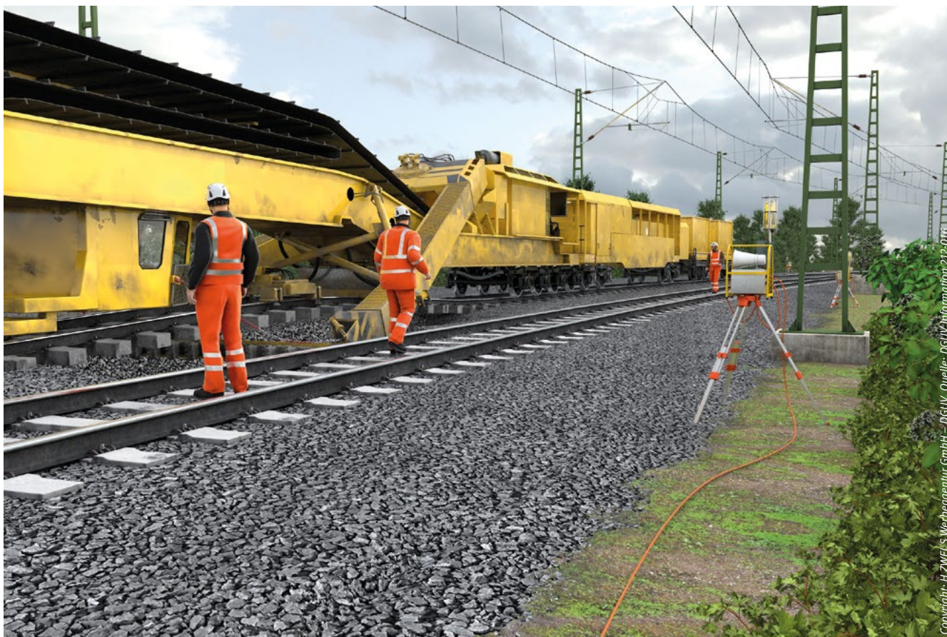
Abbildung 2: Maschinenbediener im Nachbargleis: Empfehlung Warnkleidung Klasse 3
