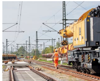
Gleisbauarbeiten auf der Riedbahn bei Riedstadt-Goddellau.
