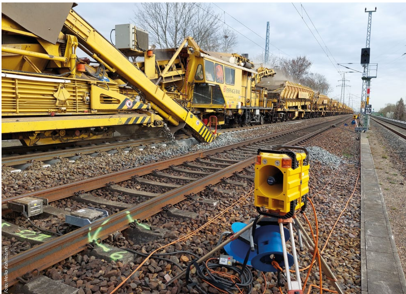
Sicherung einer Bettungsreinigungsmaschine mit ATWS
