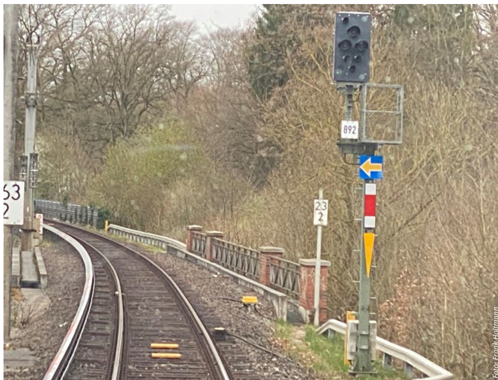
Dunkelgeschaltetes Einfahr-signal 892 in ETCS L2 für den in Kürze vorbeifahrenden Zug
