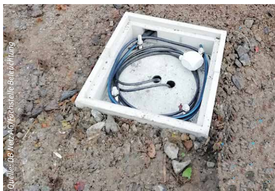
Abbildung 10: Fertigteilfundament für die nGgB (verbaut)
