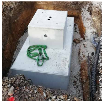
Abbildung 9: Fertigteilfundament für die nGgB (offen)
