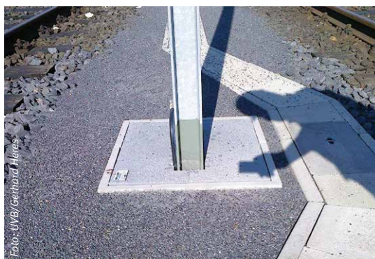
Abbildung 11: Vertiefter Einbau eines Mastes ohne Stolperstelle (Endzustand)
