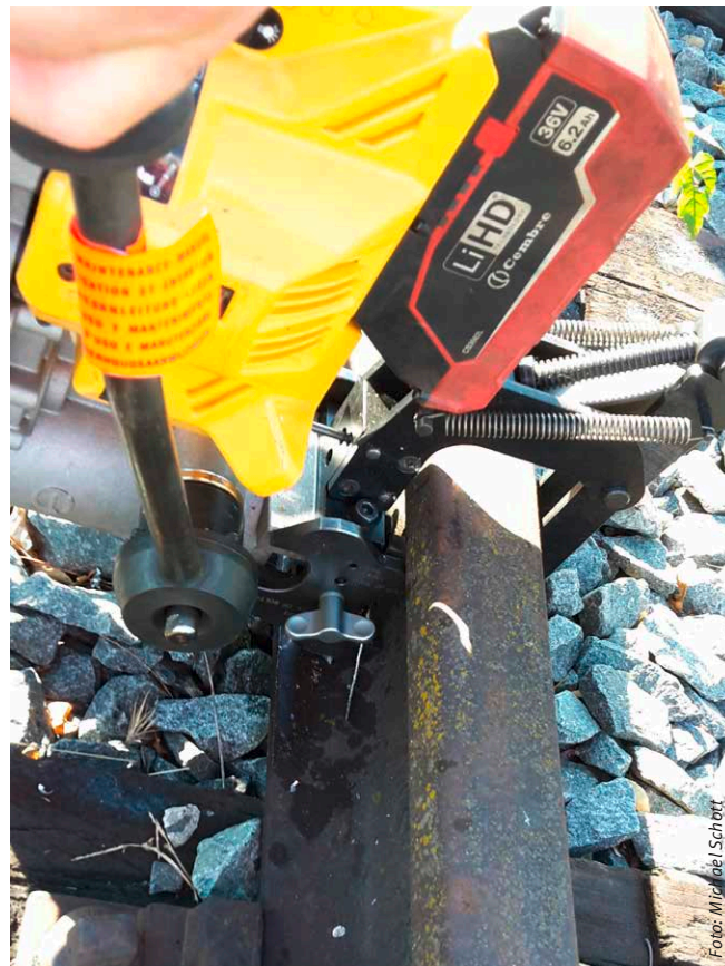
Abbildung 4: Schienenbohr- maschine beim Bohren
