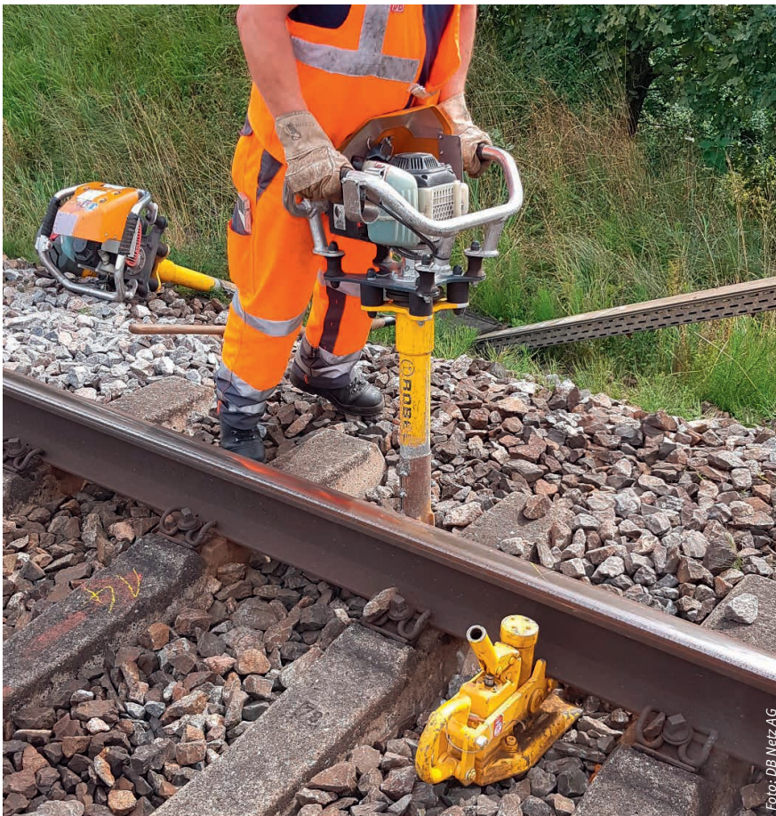
Handstopfarbeiten mit Vibrationsstopfer
