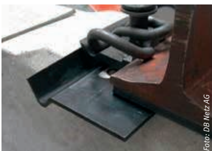
Einlegen der Höhengleichplatten
