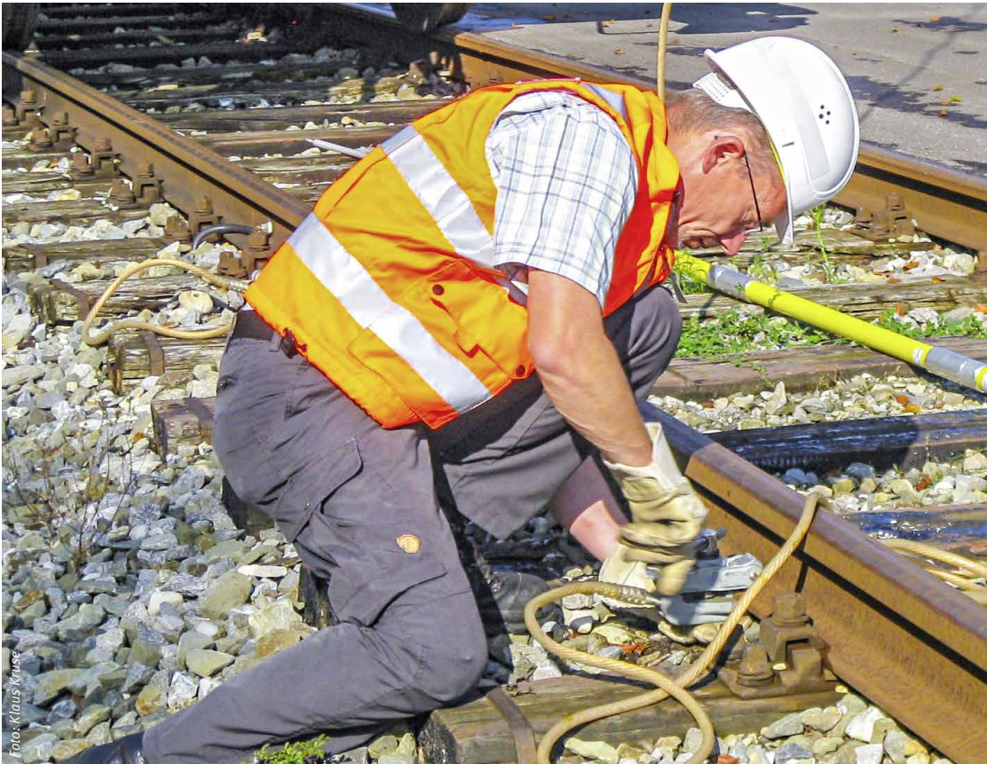
Notfallmanager bringt Schienenfußklemme an
