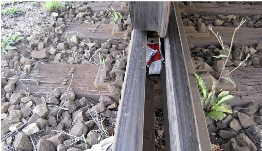
Abbildung 10: Eingeklemmte Zugschlusscheibe zwischen Zunge und Backenschiene einer Weiche
