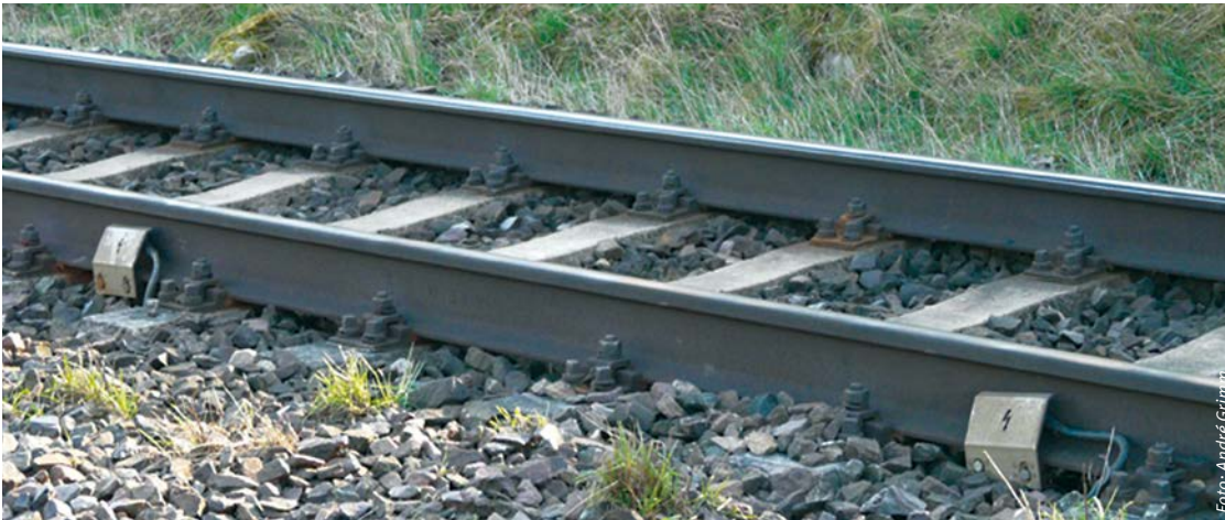
Abbildung 2: Betriebsserden an einer Weichenheizung
