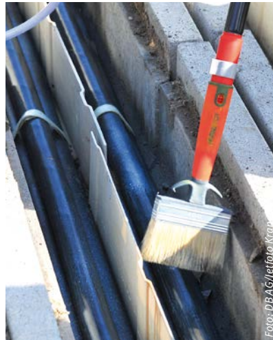
Die DB Netz AG führt in gefährdeten Bereichen eine Kabelmarkierung mit Markierungsflüssigkeit und Mikroplättchen durch
