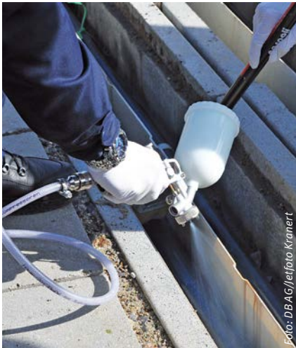
Die DB Netz AG führt in gefährdeten Bereichen eine Kabelmarkierung mit Markierungsflüssigkeit und Mikroplättchen durch
