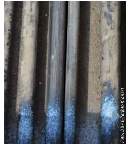
Die DB Netz AG führt in gefährdeten Bereichen eine Kabelmarkierung mit Markierungsflüssigkeit und Mikroplättchen durch
