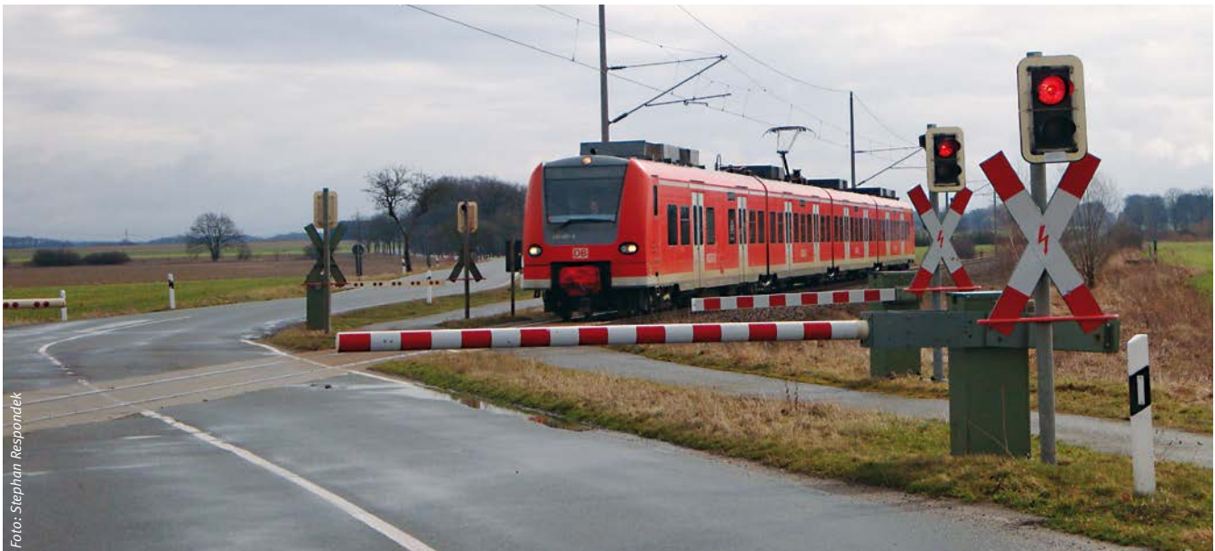
Blinklichtanlage mit Fußgängersignalen und Schranken nur für die Zufahrtrichtungen
