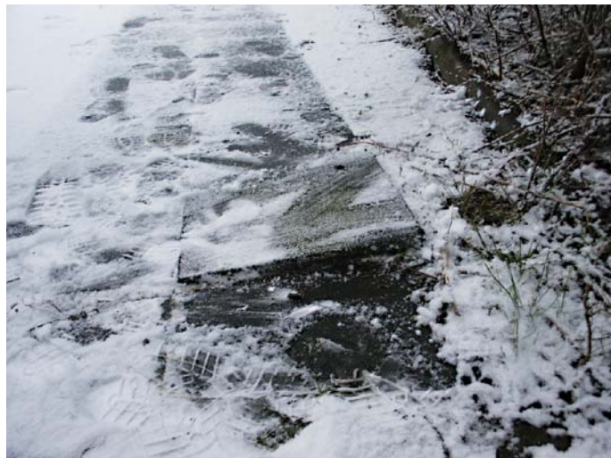
Stolperstelle durch hochstehende Steinplatte
