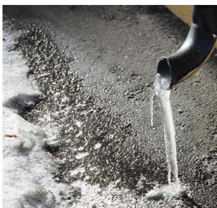
Oben: Regenwasserabführung in den Verkehrsweg Unten: Wasserlache im Verkehrsweg
