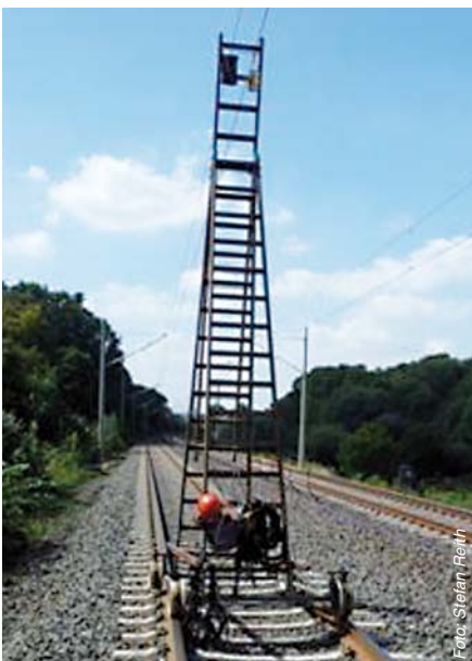
Abbildung 4: Restarbeiten an der Oberleitung mit einer schienenfahrbaren Leiter
