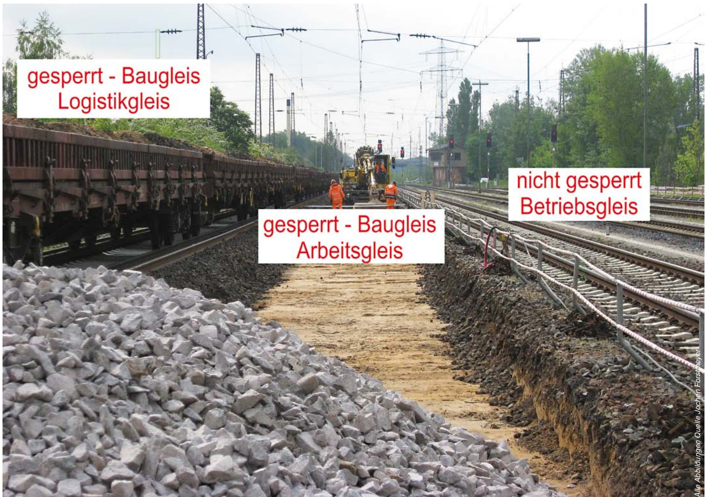
Abbildung 1: Nachbargleis ist umgebaut, bleibt gesperrt und Baugleis, wird als Logistikgleis benutzt
