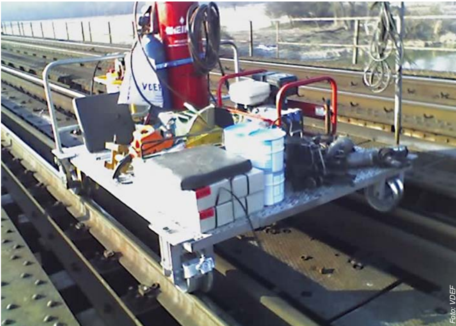
Abbildung 3: Mit Baumaterialien und Werkzeug beladener Rollwagen bei einer Brückensanierung
