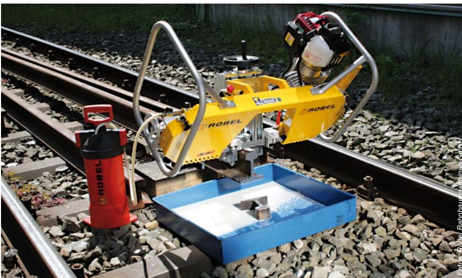
Abbildung 2: Schienensäge ist am Gleisoberbau (Schiene) befestigt
