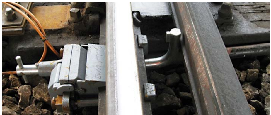
Abbildung 7: Weichenschloss anklebbar. Schlüssel kann nur entnommen werden, wenn Weichenzunge ablegt und Drehriegel bedient wurde
