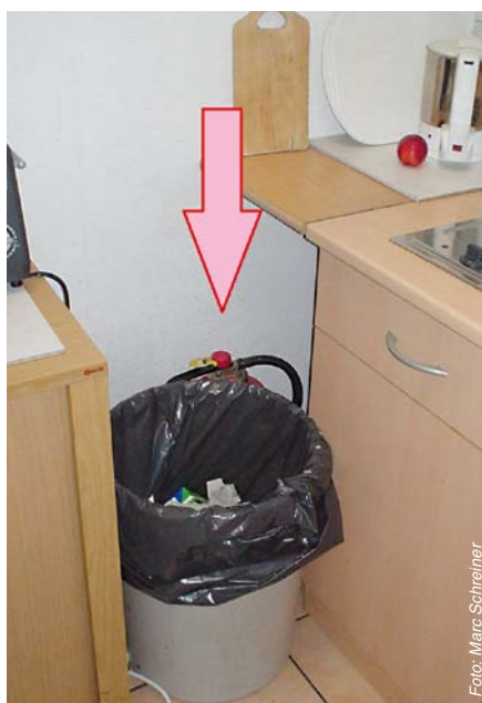
Abbildung 2: „Griffbereite“ Feuerlöscher, so nicht!...
