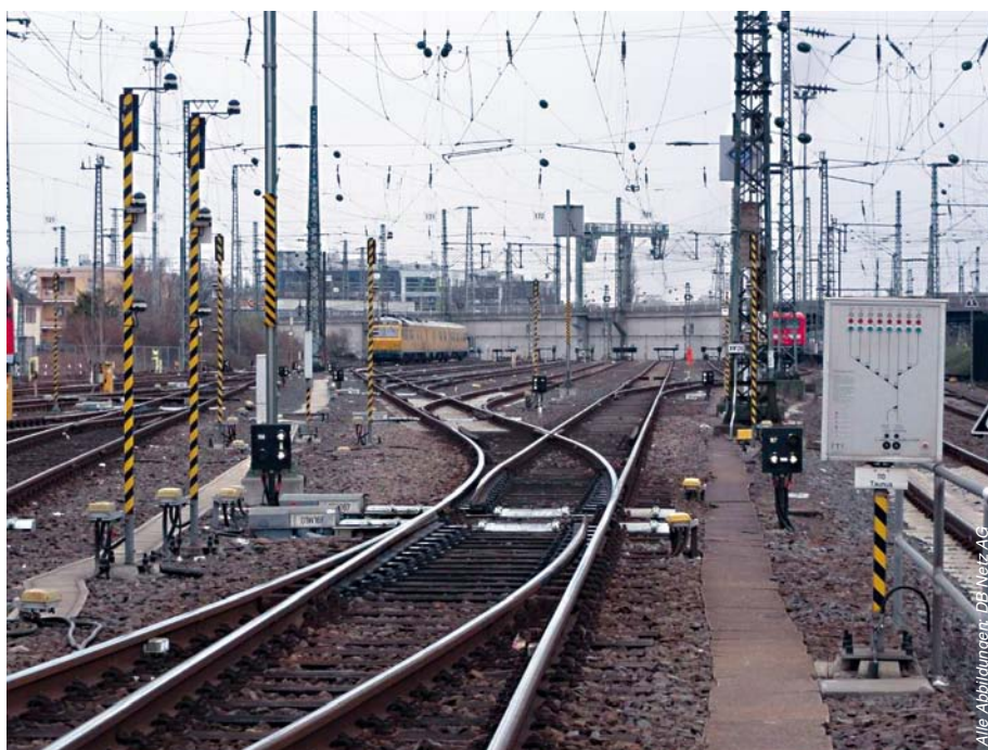
Abbildung 3: Elektrisch Ortsgestellte Weiche
