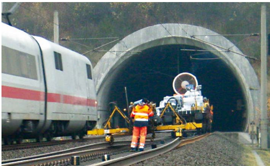
Abbildung 4: Schienenwechsel im Tunnel bei mitgeführter Belüftung.
