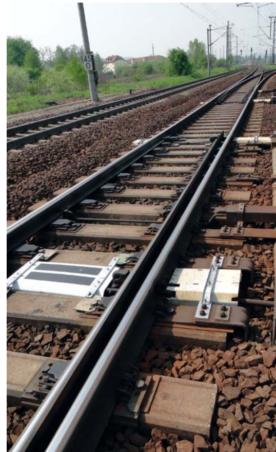
Abbildung 3: DB-Verschlussfachabdeckung (Mittelteile am Spitzenverschluss noch nicht montiert) (Foto: Menius)
