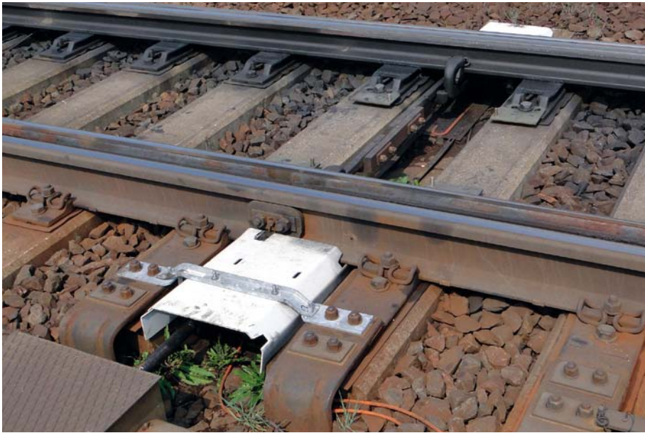
Abbildung 1: Verschlussfach mit 2 x 250 W Verschlussfachheizung Heizstab (gebogen). Außerdem sieht man die beginnende Montage Verschlussfachabdeckungen (Foto: Menius)
