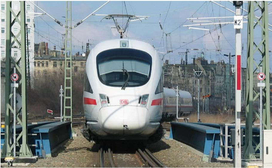
Abbildung 6: Brückenbauwerk mit „fehlender Ausweichmöglichkeit“
