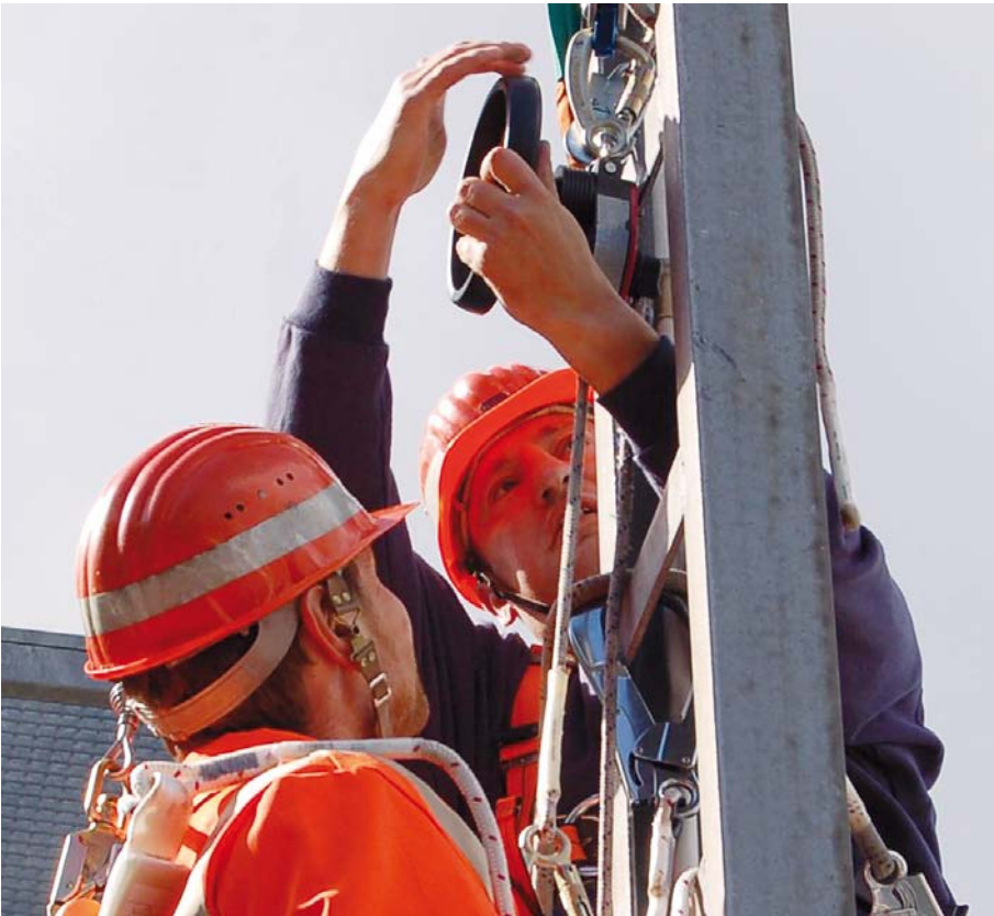
Abbildung 9: Höhenrettung mittels Rettungshubgerät.
