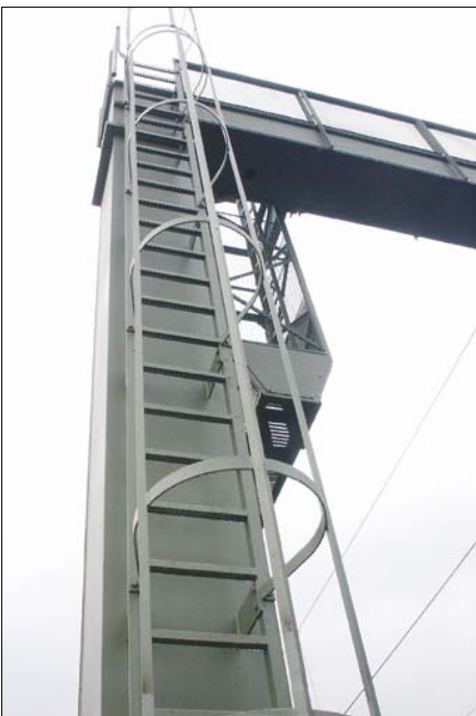
Abbildung 6, unten: Absturzsicherung durch Umwehrung und Geländer.
