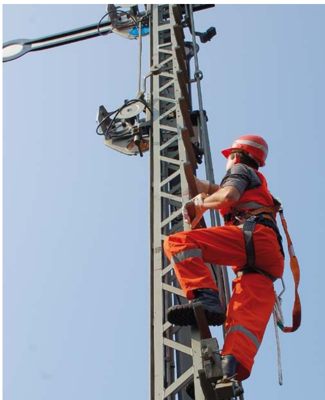
Abbildung 1: Bei der „Drei-Punkt-Methode“ kann ein falscher Handgriff oder Fehltritt zum Absturz führen.
