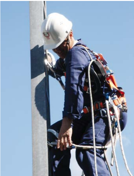
Abbildung 4, oben links: Besteigen eines Mastes in der Y-Seil-Methode, der Beschäftigte kann sich jederzeit in jeder Situation sichern.
