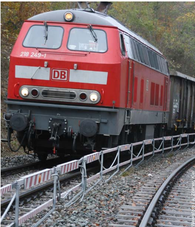
Abbildung 1: Feste Abspernung FALKON in 1.900 Millimeter Abstand von Gleismitte des Betriebsgleises installiert.
