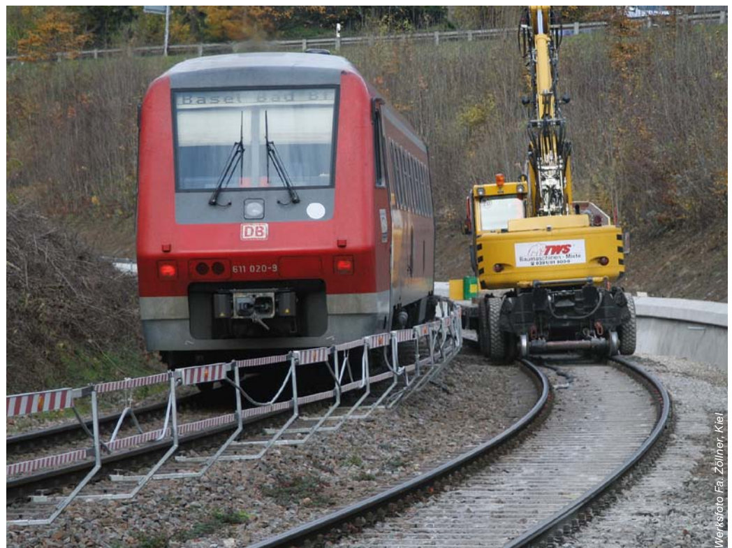
Abbildung 2: Verbleibender Arbeitsraum bei 3,60 Meter Gleisabstand.
