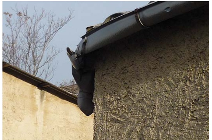
Abbildung 7: Defekte Dachrinne
