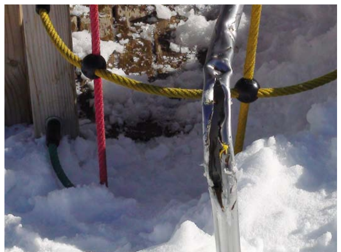
Abbildung 8: Beschädigung durch Räumfahrzeug
