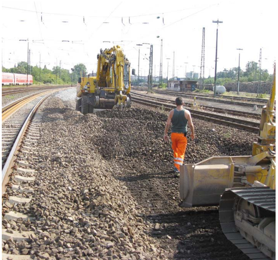
Abbildung 9: Zweiwegebagger und Raupenfahrzeug im Schotterbereich, für beide Fahrzeuge gelten die gleichen Einsatzbedingungen
