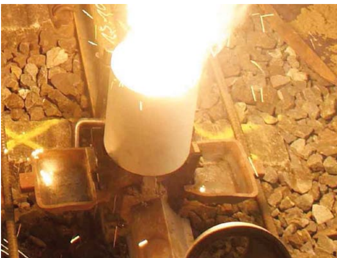
Abbildung 6, unten: AS-Schweißung
