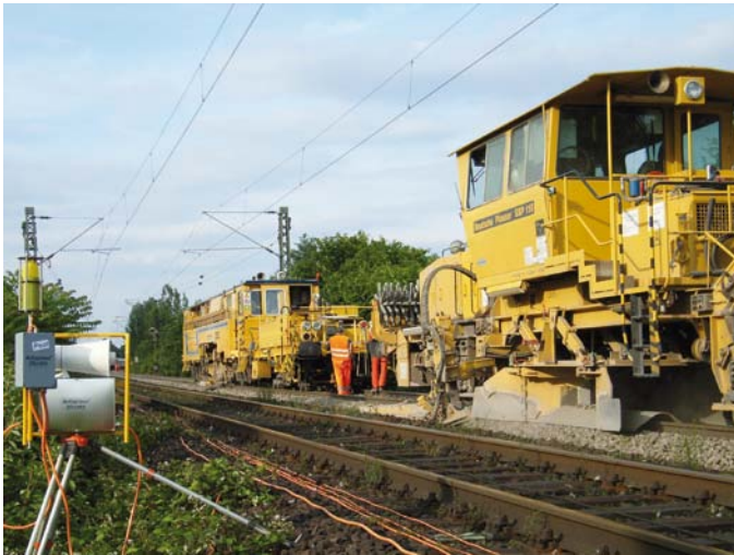
Abbildung 10: Stopfmaschine (im Hintergrund mit Messtrupp) und Schotterplaniermaschine.
