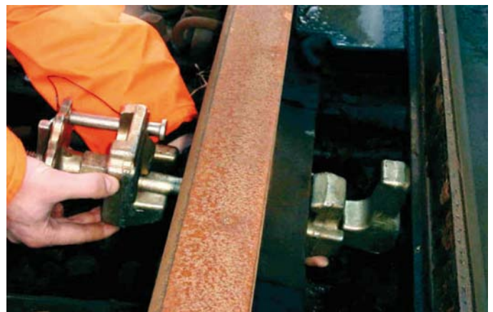
Schritt 4: HV 73 in den Schienenfuß einhängen.
