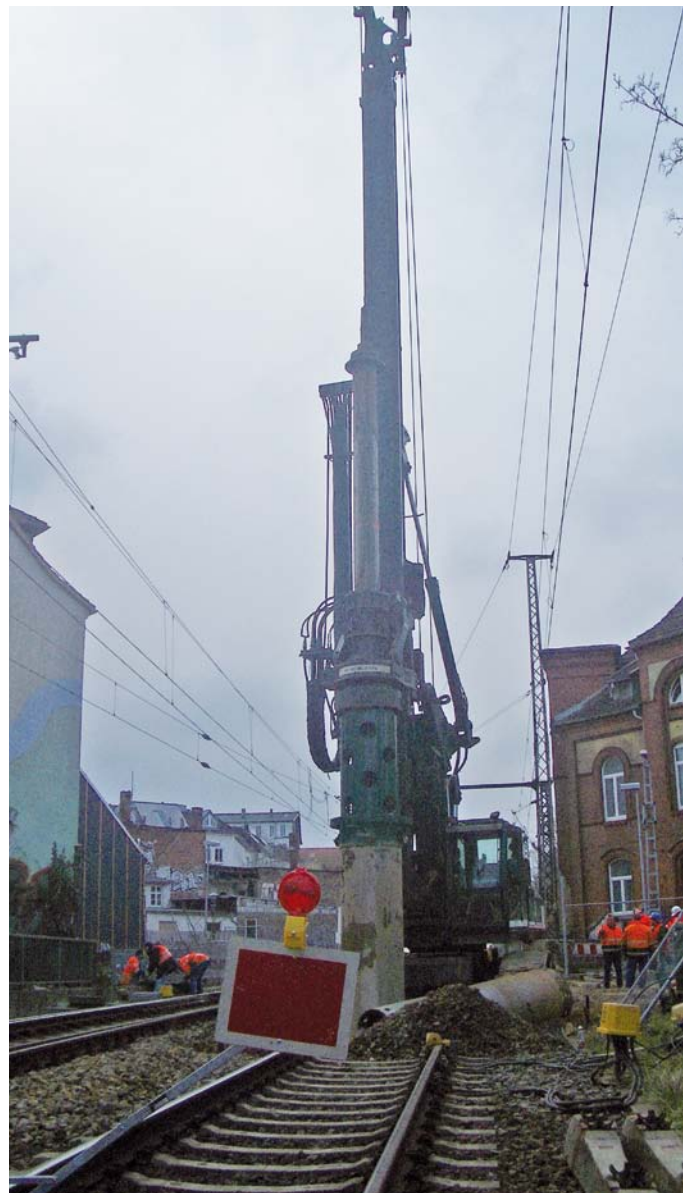
Abbildung 12: Einsatz eines Drehbohrgerätes im gesperrten Gleis.
