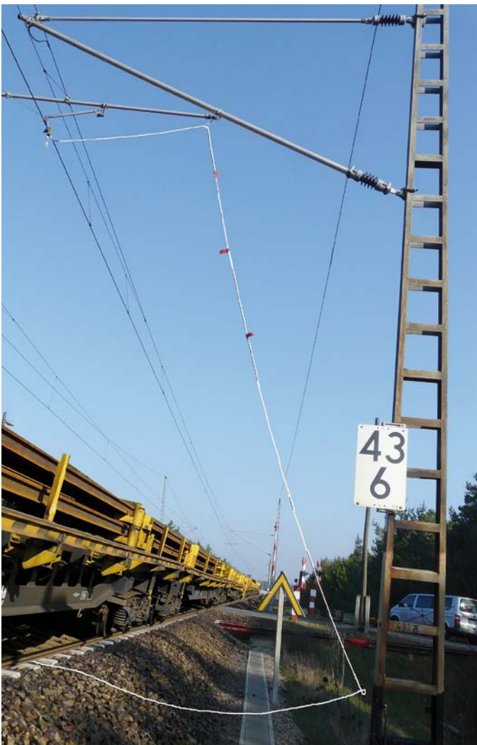
Abbildung 5, unten: Geerdete Oberleitung bei der Entladung von Langschienen. Alle Fotos in diesem Beitrag: Grimm.
