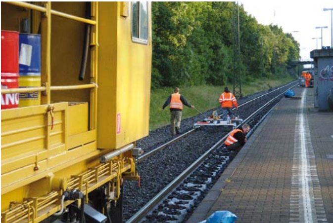
Abbildung 2, oben: Rückwärtsfahrbewegung einer Stopfmaschine und Mess-trupp im Baugleis. Der Führerstand in Fahrtrichtung ist hier nicht besetzt.
