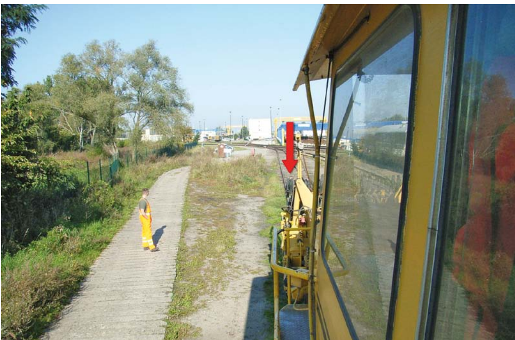
Abbildung 7: Aus den seitlichen Kabinenfenstern der Schotterplaniermaschine ist die Sicht auf den Fahrweg stark eingeschränkt (Mitarbeiter in gebückter Position ca. 15 m hinter der Maschine).
