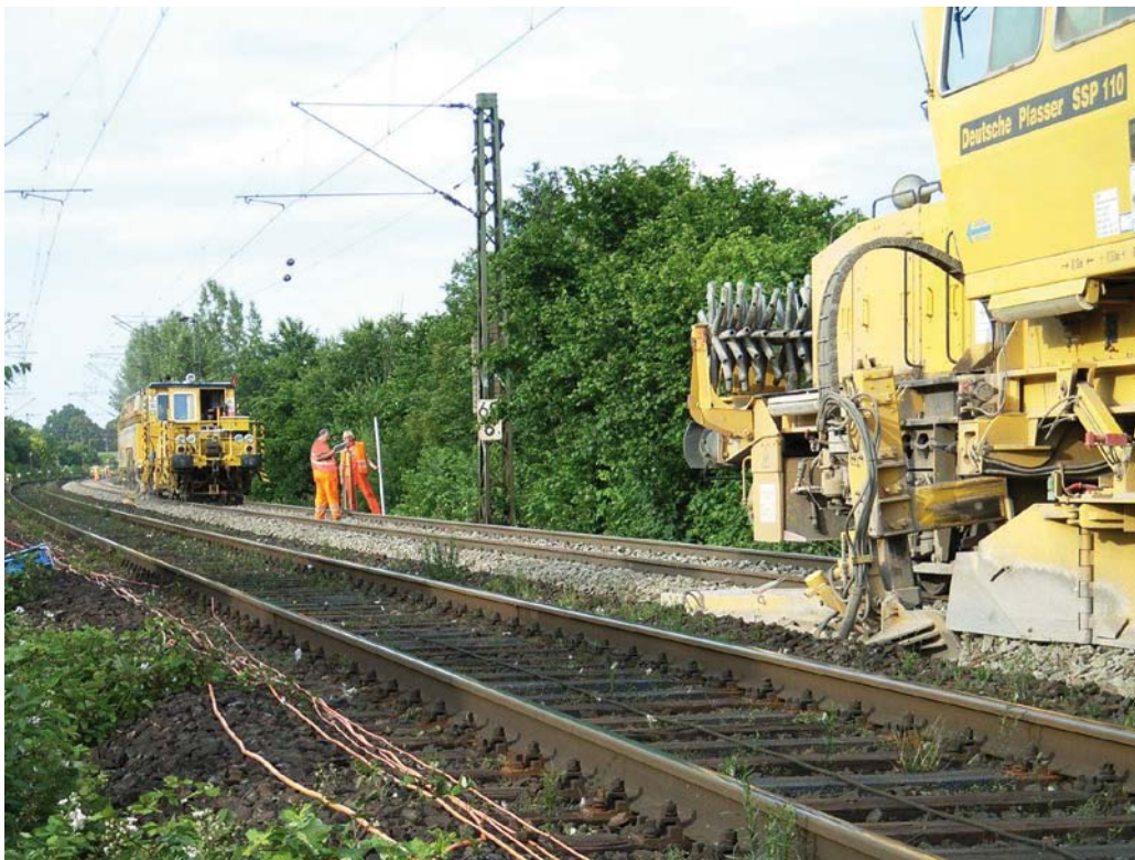
Abbildung 1: Messtrupp zwischen Stopfmaschine und Schotterplaniermaschine.
