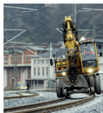
Unser Titelbild: Zweiwegebagger im Einsatz.
