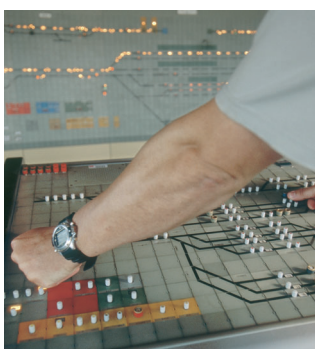
Unser Titelbild: Fahrstraßeneinstellung in einem Gleisbildstellwerk. Foto: DB AG/Schmid.
