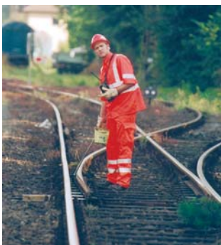
Unser Titelbild: Arbeiten im Gleisbereich. Foto: EUK.
