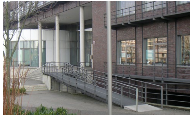
Abb. 4 Rampe im Außenbereich mit Gitterrostbelag
