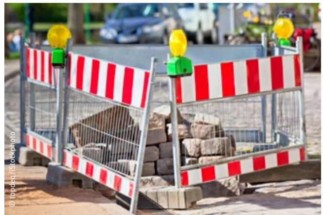
Abb.3 Baustelle mit Baken und Lichtzeichen gesichert
