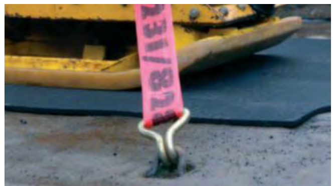
Abb. 56 Einsatz einer Antirutschmatte
