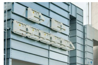
Druckentlastung über Explosionsklappen
