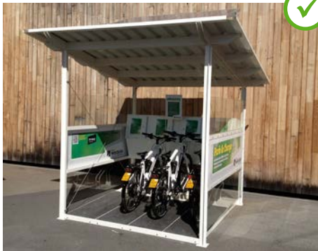
Abb. 17 Öffentliche Ladestation an einem Einkaufszentrum
