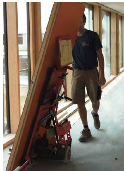
Abb. 74 Durch Hebe-/ Transportroller bzw. Treppenroller entfällt manuelles Tragen
