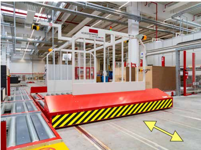
Abb. 87 Absicherung im Bodenbereich durch Bumper
