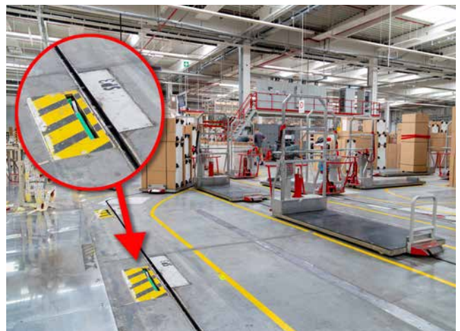
Abb. 89 Auskoppelstelle des Schleppkettenförderers
