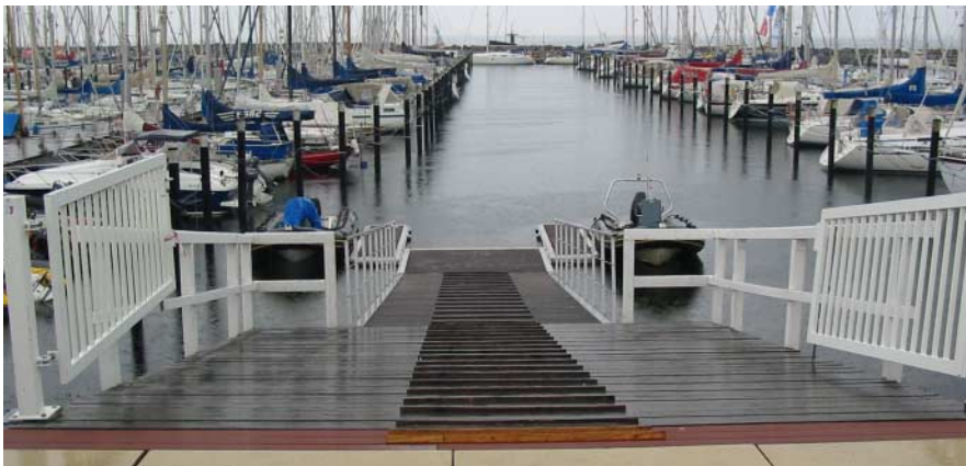
Ausreichend dimensionierte Anlage zum Wassern kleiner Boote
