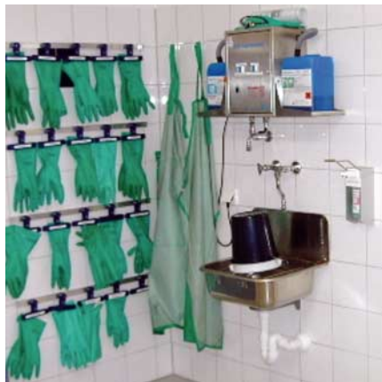
Schutzbekleidung zur Reinigung und Desinfektion
