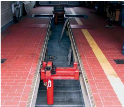
Typische Arbeitsgrube im Werkstattbereich
