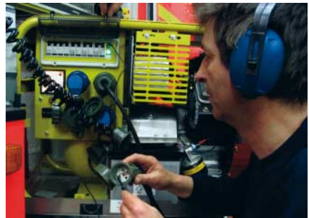
Überprüfung der Schutzmaßnahme eines tragbaren Stromerzeugers
