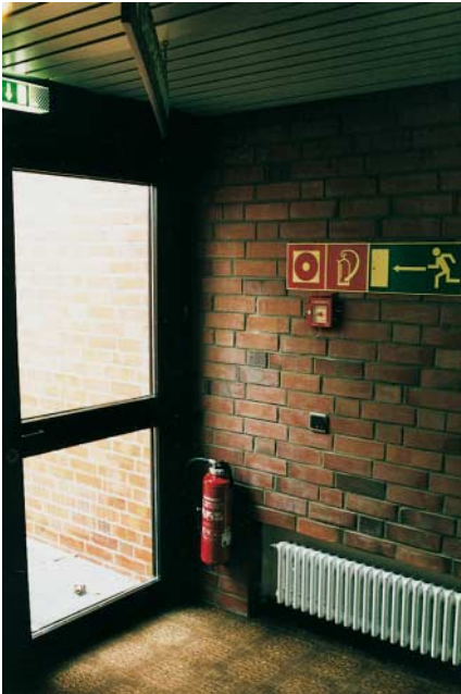
Notausgang in einem Stützpunkt mit Kennzeichnungen und Feuerlöscher
