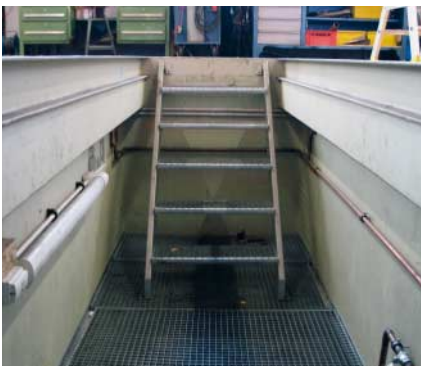
Beleuchtung in der Arbeitsgrube – die eingebauten Leuchten entsprechen der Schutzart IP 54.
