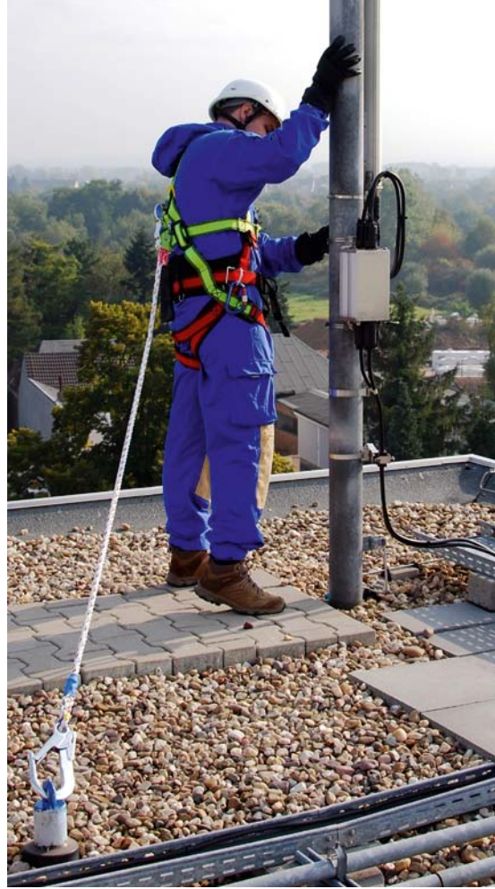
Bild 11 PSaGA in Rückhaltefunktion
