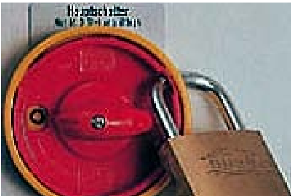
Bild 19 abschließbarer Hauptschalter nach DIN EN 60947-1
