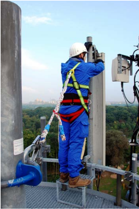
Bild 12 Gesichertes Arbeiten an einer Absturzkante
