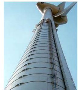
Bild 23 Funkanlage auf einer Windkraftanlage
