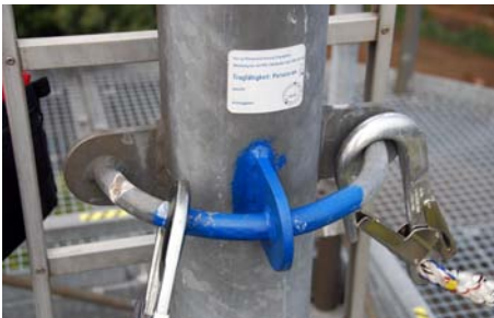
Bild 13 Kennzeichnung eines Anschlagpunktes mit Angabe der Tragfähigkeit
