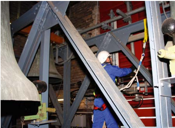
Bild 18 Arbeiten an einer Funkantenne in der Glockenstube
