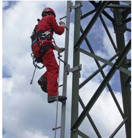
Abb. 46 Beispiel für einen Steigbolzenangang. Um die Absturzhöhe möglichst gering zu halten, ist hier jeder vierte Steigbolzen mit einer Sicherheitseinrichtung ausgeführt.
