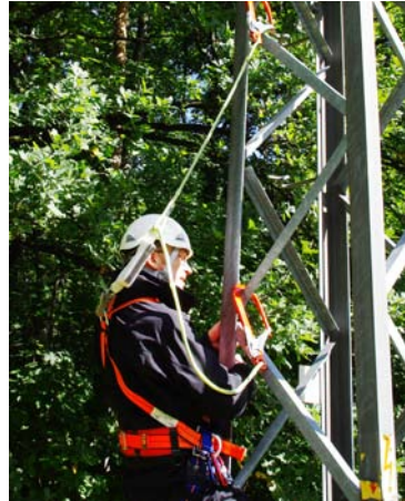
Abb. 17 Auffangsystem mit Falldämpfer: Der Auffanggurt wird über ein Verbindungs-mittel und einen Falldämpfer mit einem Anschlagpunkt am Mast verbunden. Der Anschlagpunkt liegt möglichst oberhalb des Arbeitsplatzes.
