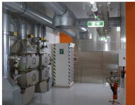
Abb. 4 Bau für S3-Experimente
