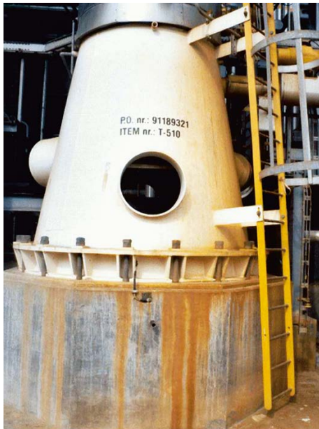
Abb. 8 Schuss unter einer Kolonne
