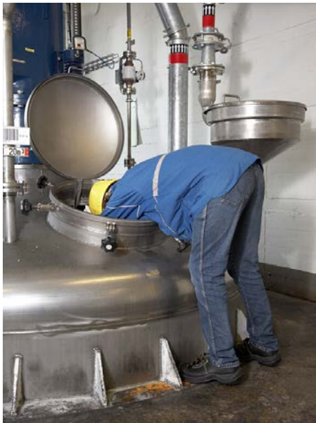
Abb. 3 Kontrolltätigkeiten (Hineinbeugen): nur mit zusätzlichen Schutzmaßnahmen möglich, hier: ein Schutzgitter im Mannloch, welches ein Hineinstürzen verhindert.
