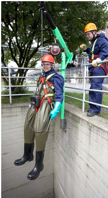
Abb. 25 Zugangsverfahren mittels Auffanggurt und Rettungswinde
