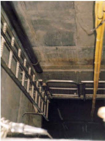
Bild 8: Steigleiter mit Seitenholmen, Steigschutzeinrichtung und Podest
